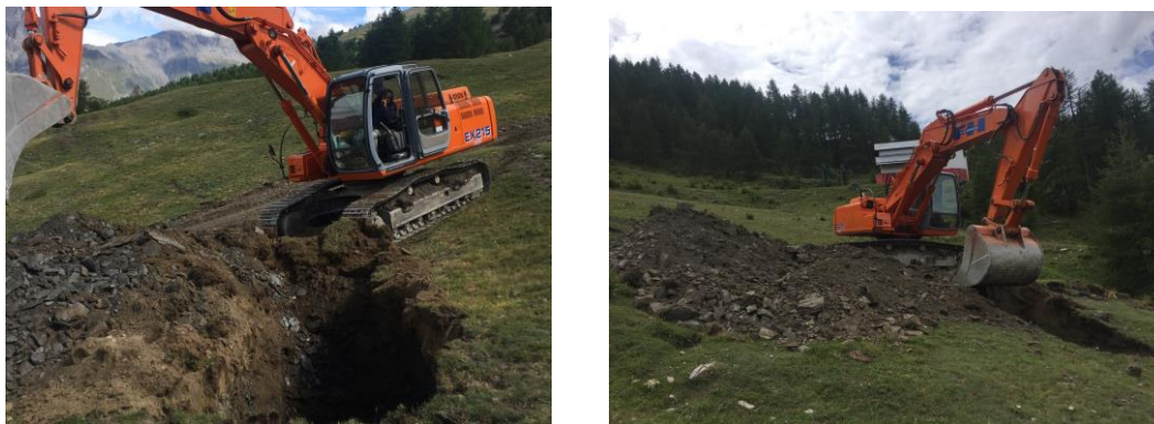
Figura 8. Esecuzione pozzetti geognostici (campagna di indagini 2017)
